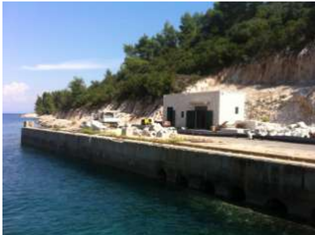
Slika 6.: Pogled na objekt UPOV i CS Bristva
