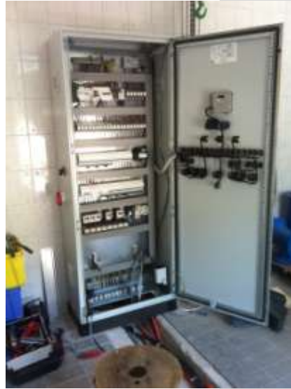
Slika 4.: Upravljački elektroormar
