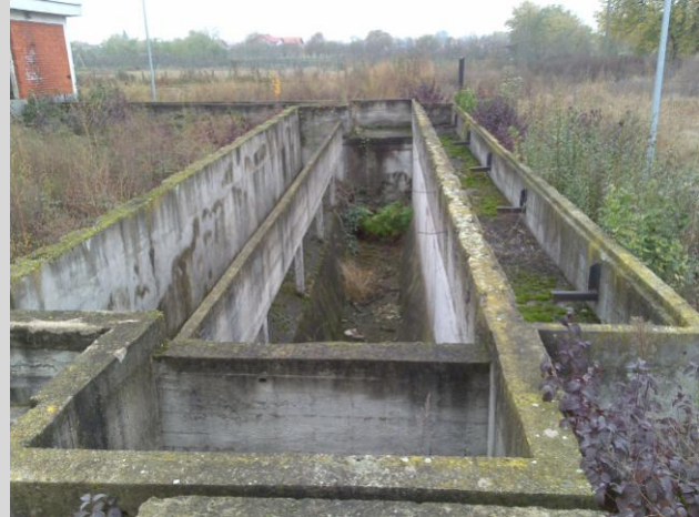
Slika 4: Postojeći objekt – Aerirani pjeskolov – mastolov
