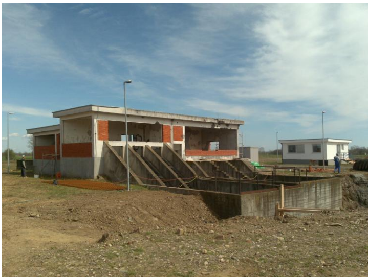
Slika 5.: Postojeći objekt – Ulazna crpna stanica
