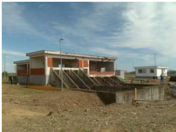
Slika 5.: Građevinski radovi na sanaciji ulazne crpne stanice sa pužnim crpkama
