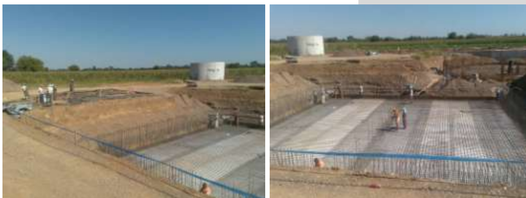
Slika 12. – 13.: Građevinski radovi na izgradnji bioeracijskih bazena i sekundarne taložnice
