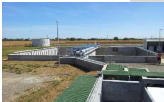
Slike 14.-18.: Ugradnja hidromehaničke opreme na biološkom dijelu uređaja – aeracijski sustav za finomjehuričastu aeraciju sa razvodnim PE cijevima, niskotlačna puhalna za aeraciju, zgrtač mulja u sekundarnoj taložnici, bioaeracijski bazen sa zgušnjivačem mulja
