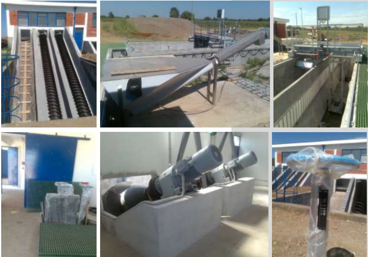
Slike 6.-11.: Ugradnja hidromehaničke opreme na mehaničkom dijelu uređaja – Ulazna crpna stanica, klasirer pijeska, automatski zgrtač pijeska i masti, kanalske zapornice, elektromotorni pogon pužnih crpki, regulacioni pločasti zatvarač
