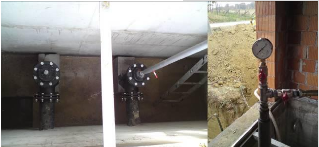
Slika 3.: Tlačna proba spojnog DUCTIL cjevovoda DN150, PN10
