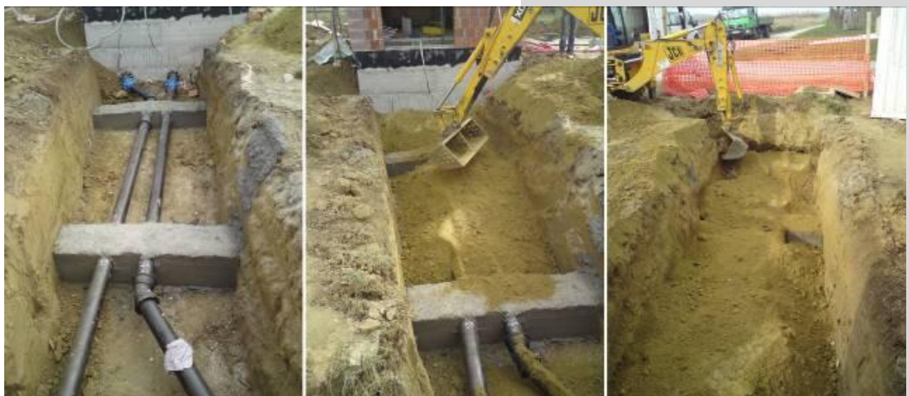
Slika 4.: Zatrpanje spojnog DUCTIL cjevovoda DN150, PN10 nakon tlačne probe
