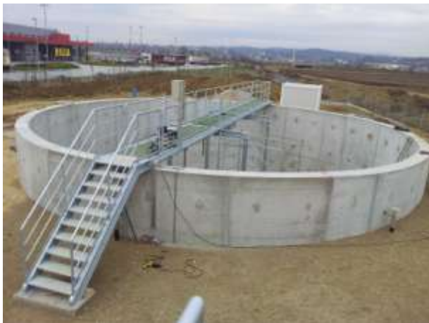
Slika 5.: Bioeracijski baten
