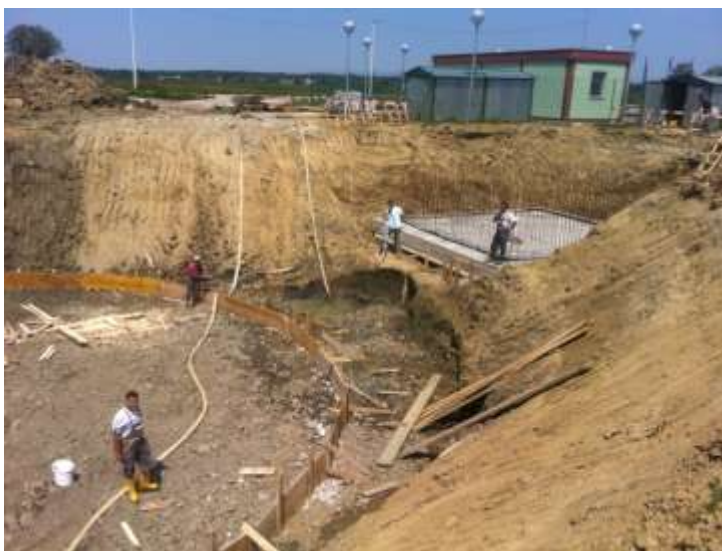
Slika 2.: Bioaeracijski bazen – oplata donje ploče
