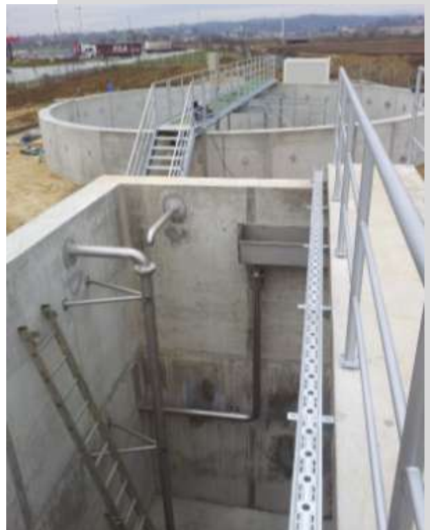
Slika 6.: Spremnik za višak mulja
