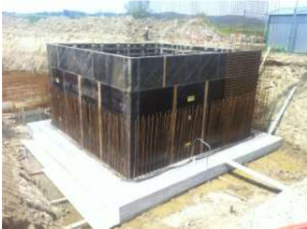
Slika 3.: Spremnik za višak mulja
